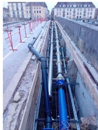
L'ancienne conduite de refoulement des eaux usées en Amiante Ciment a été déposée, remplacée par une nouvelle canalisation Ø200 mm en fonte dans la partie enterrée et en acier inoxydable dans le tablier du pont, sur un linéaire total de 205 mètres.
