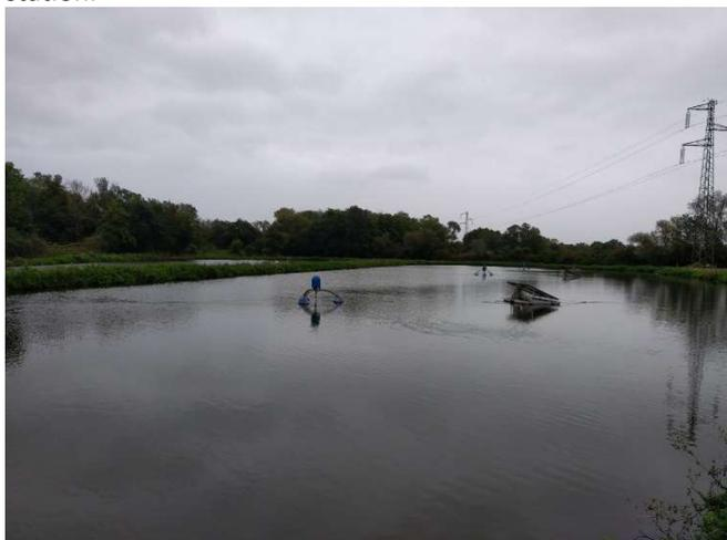
La solution technique mise en place est un système d'aération de surface de type SUNGO de AQUAGO qui a l'avantage d'être alimenté électriquement par panneau solaire.
